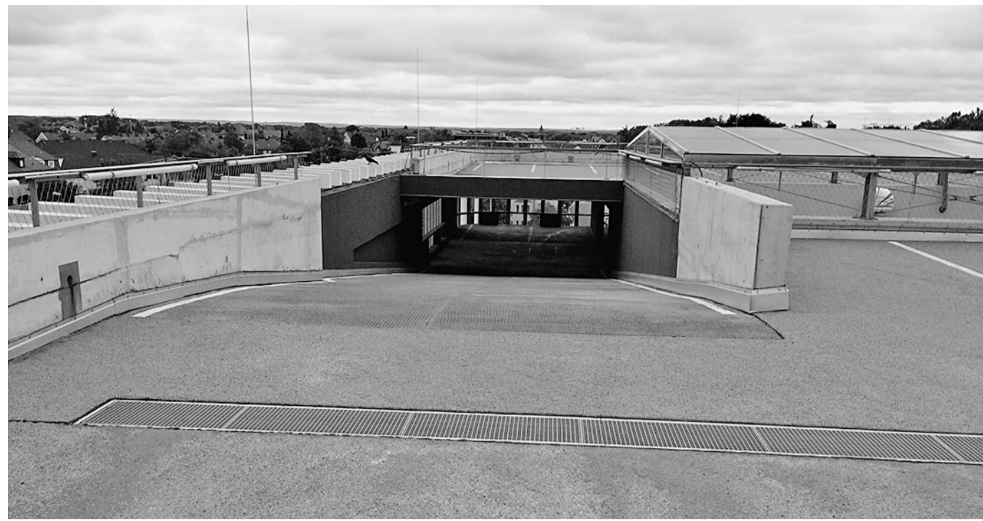
Durch die kurze Erstarrungszeit des Gussasphalts ist ein schneller Bauablauf gewährleistet. Der Belag wird bei 240 °C eingebaut und ist innerhalb von vier bis sechs Stunden abgekühlt.
